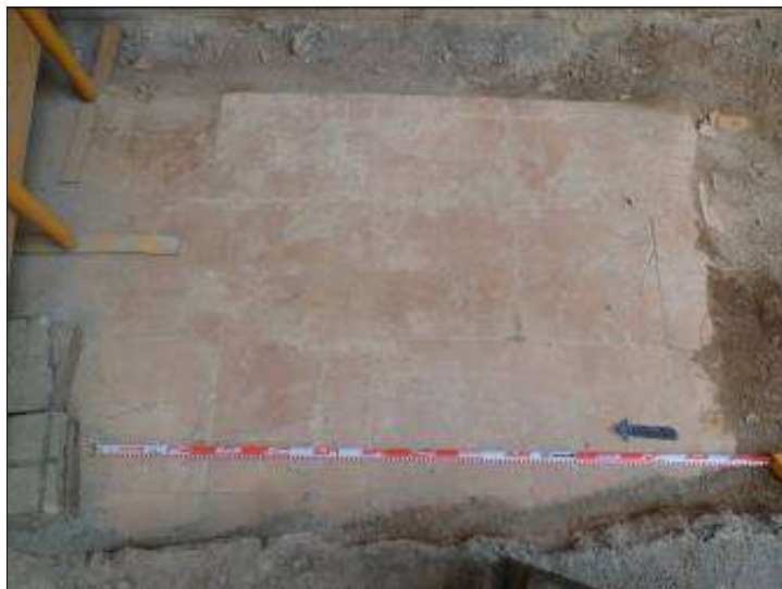
TRAM 3: MF7 Vista del paviment de gres del segle XX. Font: Carles Navarro
