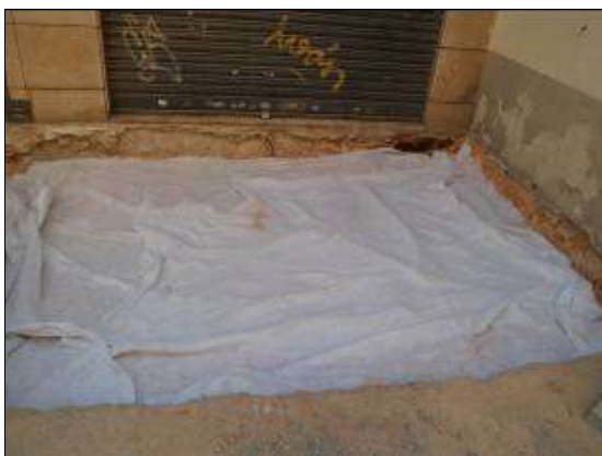
TRAM 4: Paviment 2 (P o ) Vista general i de la seva protecció amb geotètil i cobriment amb formigó. Font: Carles Navarro
