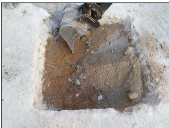
Fanal 1 (F1) Carrer Joan Torras. Vista general obertura pou fanal i del mur. Font: Carles Navarro
