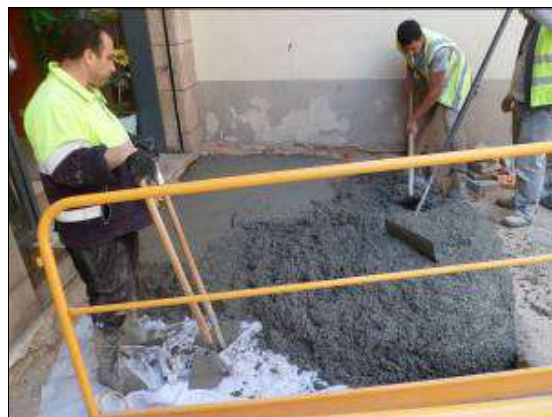
TRAM 4: Paviment 2 (P o ) Vista general i de la seva protecció amb geotètil i cobriment amb formigó. Font: Carles Navarro
