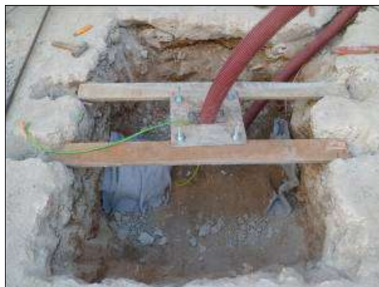
TRAM 5: Fanal 1 (F1) Obertura Fanal 1) Vista general de les estructures, protecció amb geotèxtil i cobriment amb formigó. Font: Carles Navarro
